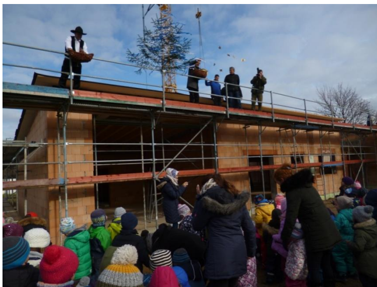
„Hebauffeier“ vom neuen Kindergarten 2017
